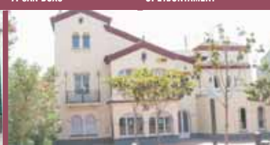
12. TORRE DE L'ARGENTERA
