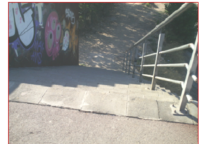
Fig. 3.2. 20 Accés des del pont de la Ctra. de l'Estació
