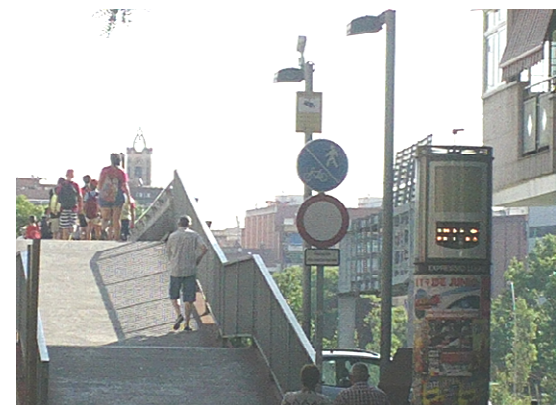
Fig. 3.2.7. Pont Ctra. de l'Estació
