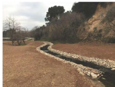
Canal de gravas sense vegetació
